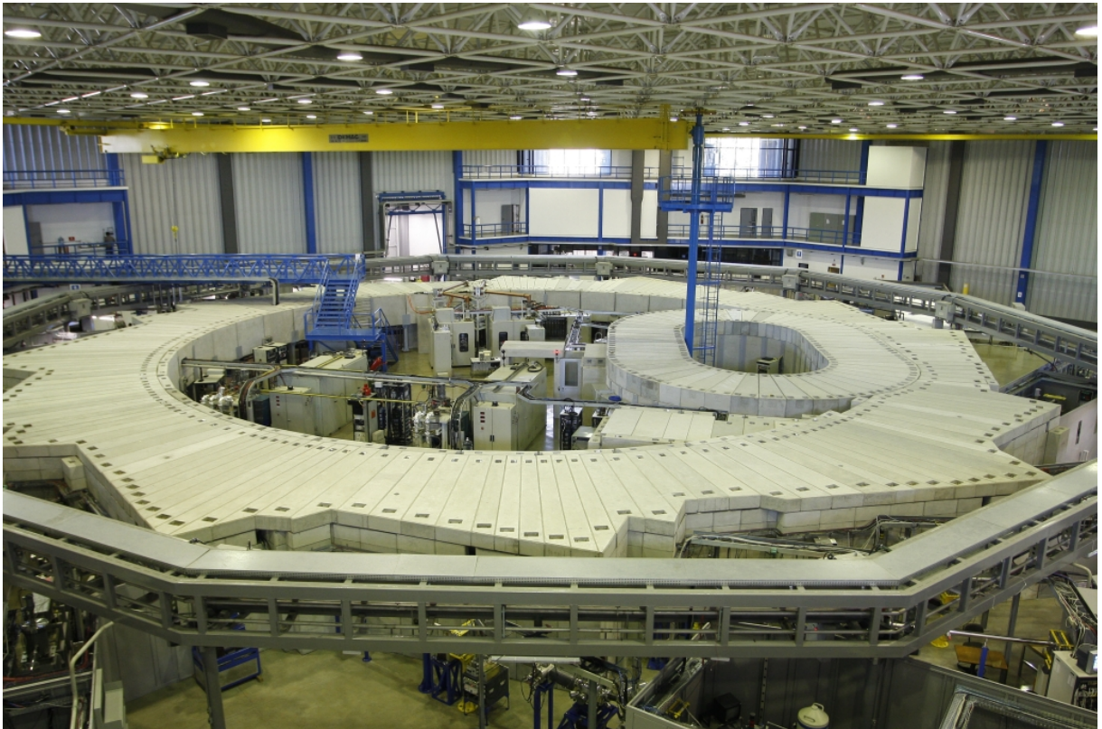
Figura 24: Foto do anel do LNLS, onde é gerada a luz síncrotron.
