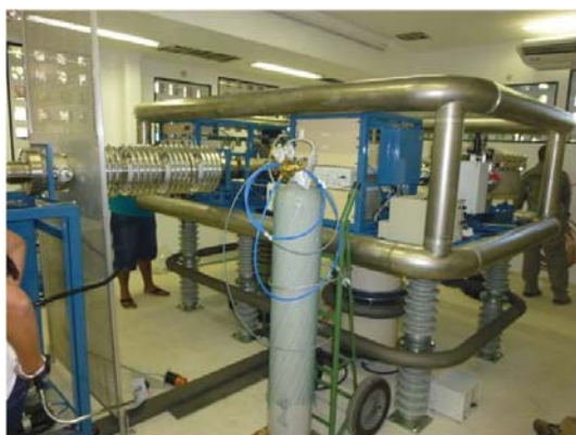
Figura A.19: 6º dia de instalação do SSAMS - 06/03/12.
