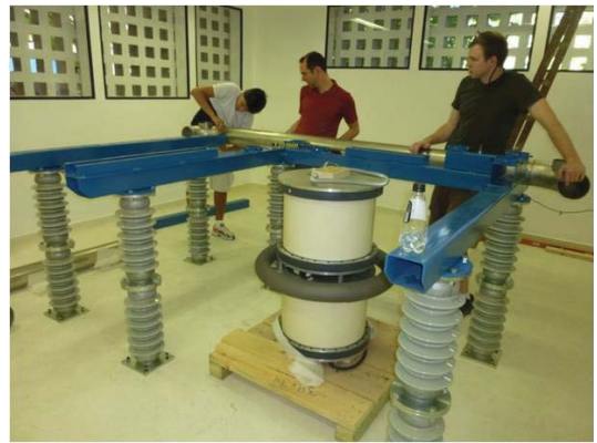
Figura A.4: 1º dia de instalação do SSAMS - 29/02/12.
