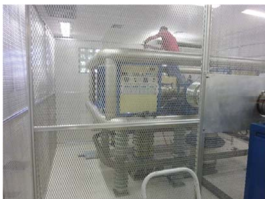
Figura A.31: 8º dia de instalação do SSAMS - 08/03/12.
