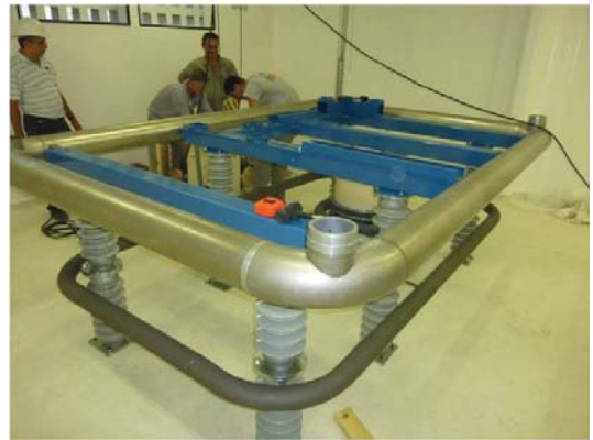
Figura A.6: 1º dia de instalação do SSAMS - 29/02/12.
