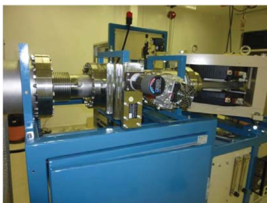
Figura A.20: 6º dia de instalação do SSAMS - 06/03/12.
