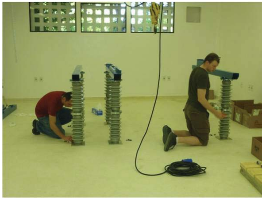
Figura A.3: 1º dia de instalação do SSAMS - 29/02/12.
