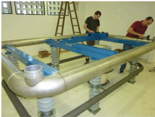
Figura A.5: 1º dia de instalação do SSAMS - 29/02/12.
