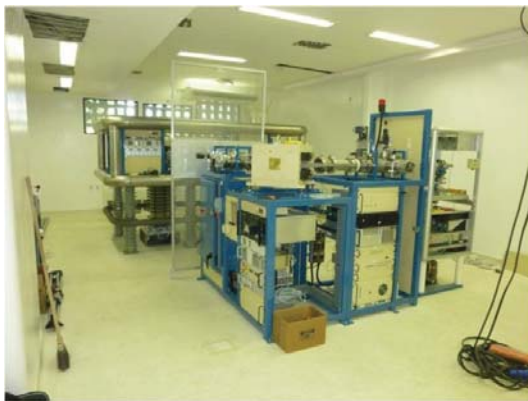
Figura A.27: Final do 6º dia de instalação do SSAMS - 06/03/12.
