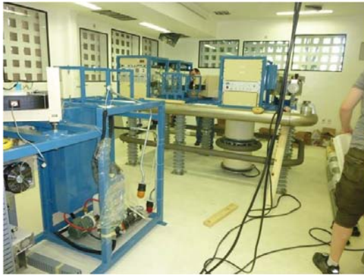
Figura A.11: 2º dia de instalação do SSAMS - 01/03/12.
