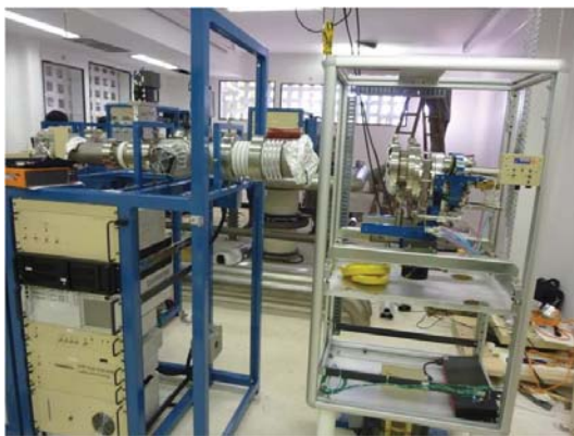
Figura A.13: 3º dia de instalação do SSAMS - 02/03/12.
